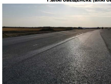
УСТРОЙСТВО ЩМА-15 С ПОЛИЭПОР-РП НА МОСТОВОМ ПЕРЕХОДЕ ЧЕРЕЗ Р.АМУР В Г.БЛАГОВЕЩЕНСКЕ (БЛАГОВЕЩЕНСК-ХЭЙХЭ (КНР))
