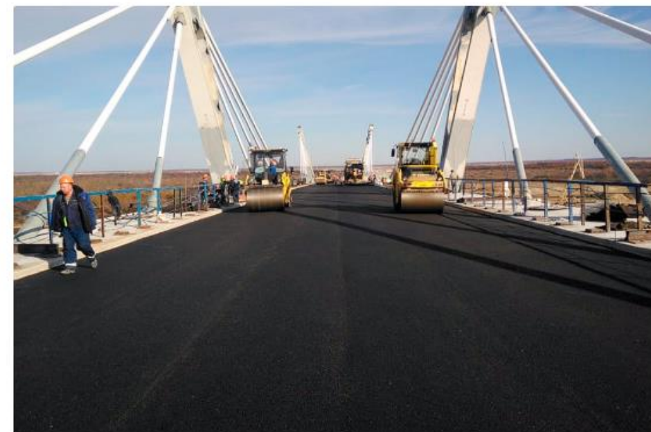
Автодорожный мост через Амур полностью заасфальтирован!
