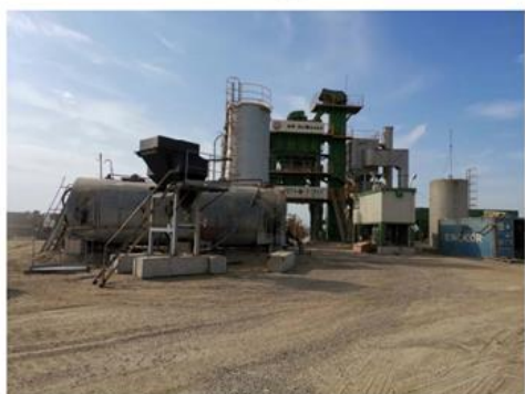
УСТАНОВКА ДЛЯ ПРИГОТОВЛЕНИЯ РПБВ-90 МОКРЫМ СПОСОБОМ НЕПОСРЕДСТВЕННО НА БИТУМНОМ УЧАСТКЕ АБЗ
